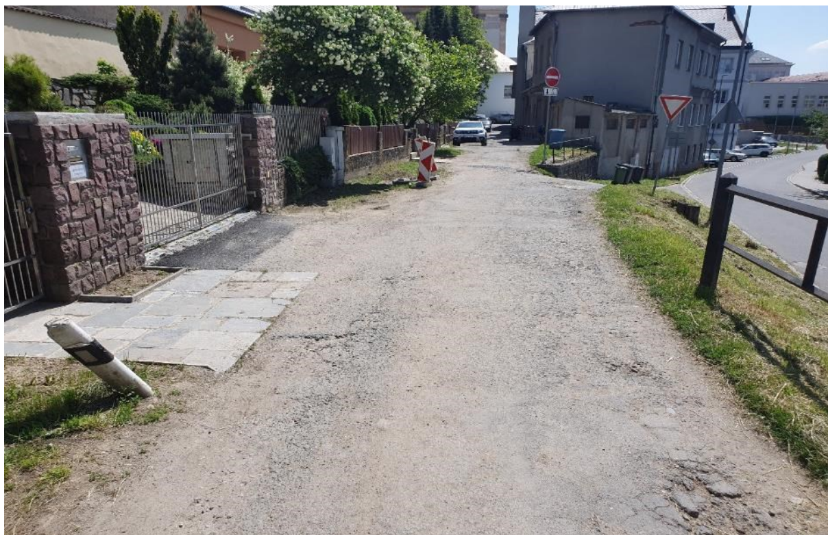
Oprava komunikace ul. Světlou
