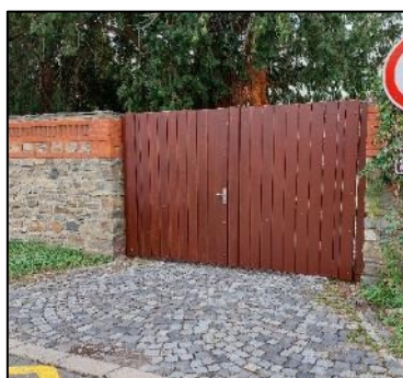
Hlavní nám. 12 - oprava vrat
