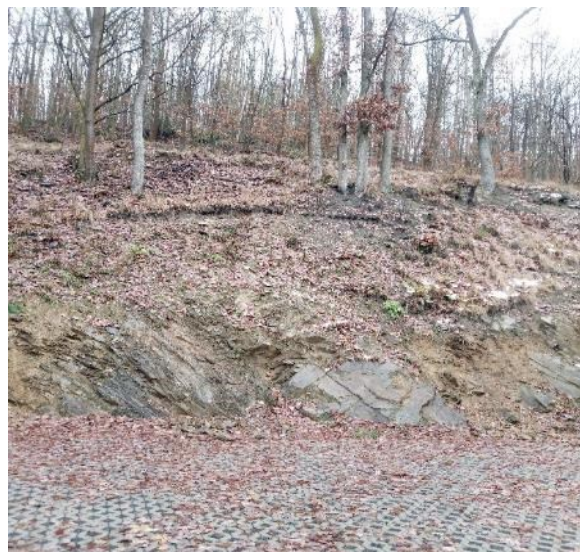
Odtěžení svahu v rozporu se zákonem (les)
