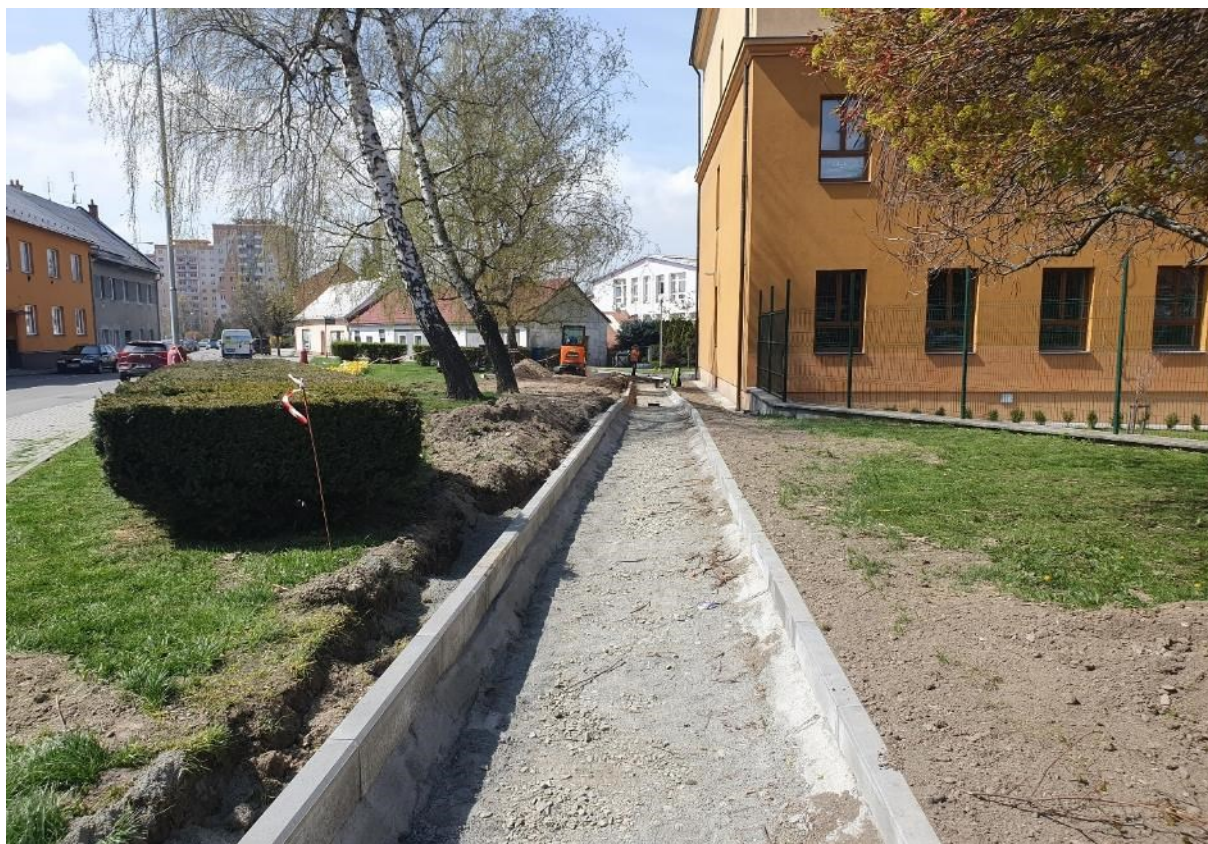
Oprava chodníku ul. Olomoucká u ZŠ
