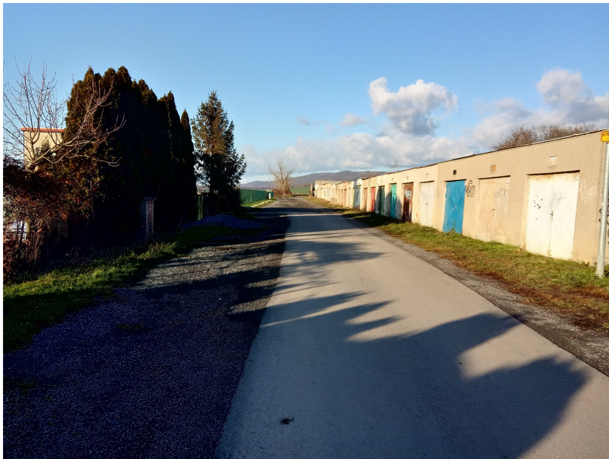
Obr. 5 – vstup do řešeného území (1), jihozápadní část řešeného území
