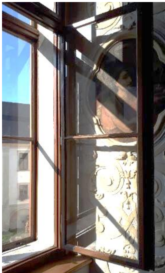
Stav oken po obnově
