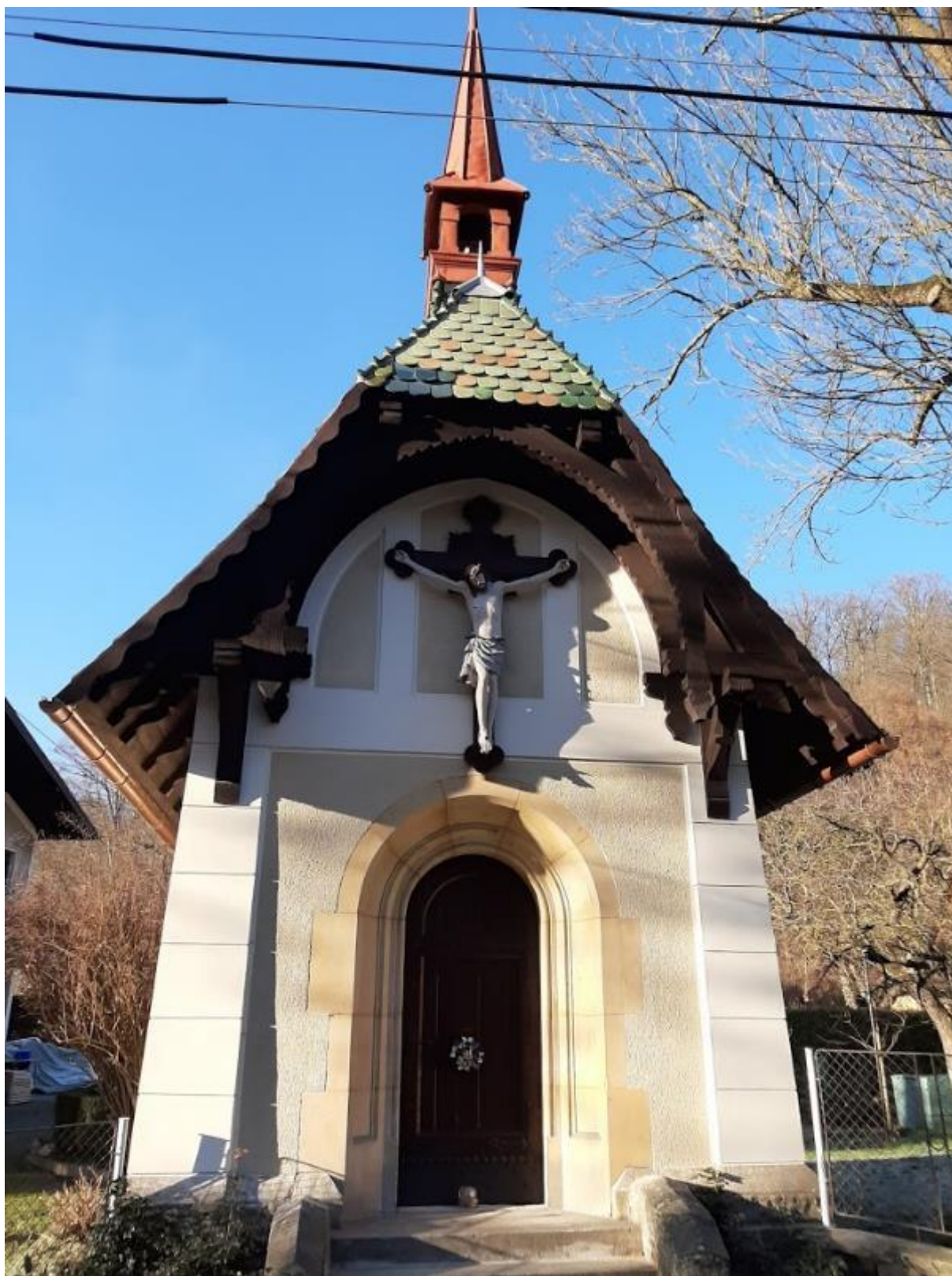
Kaple po obnově po celkové obnově
