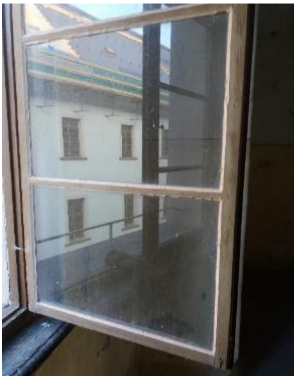
Obnova oken 2. NP – stav před obnovou
