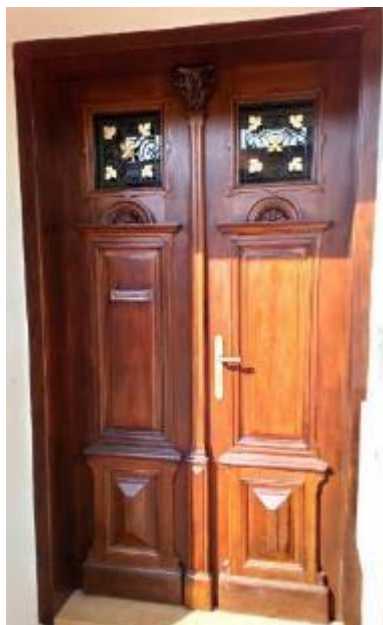
Po obnově dveří
