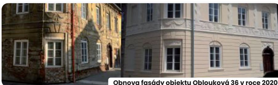
Obnova fasády objektu Oblouková 36 v roce 2020
