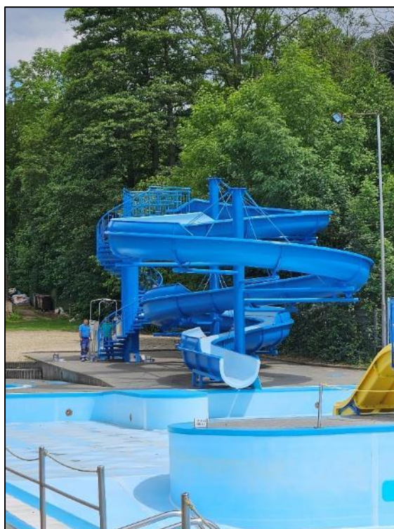
stav po opravě
