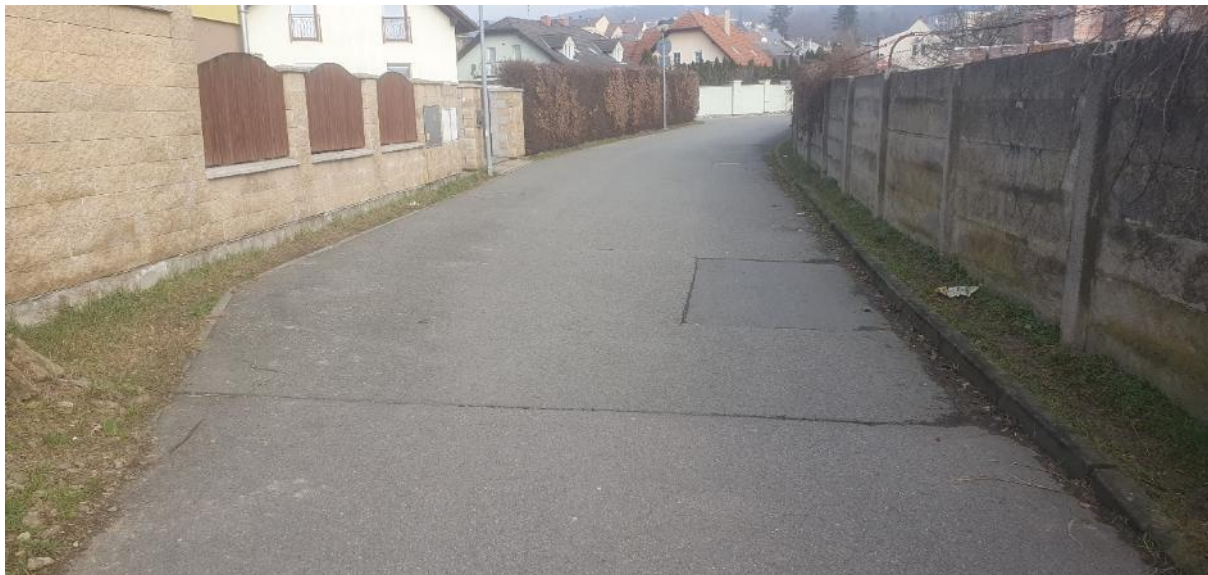
Stavební úpravy povrchu místní komunikace ulice Vinohradská
