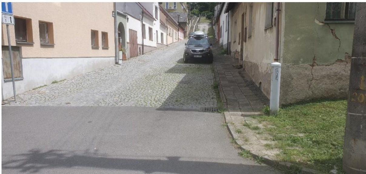
Stavební úpravy chodníku ulice Sluneční, Šternberk
