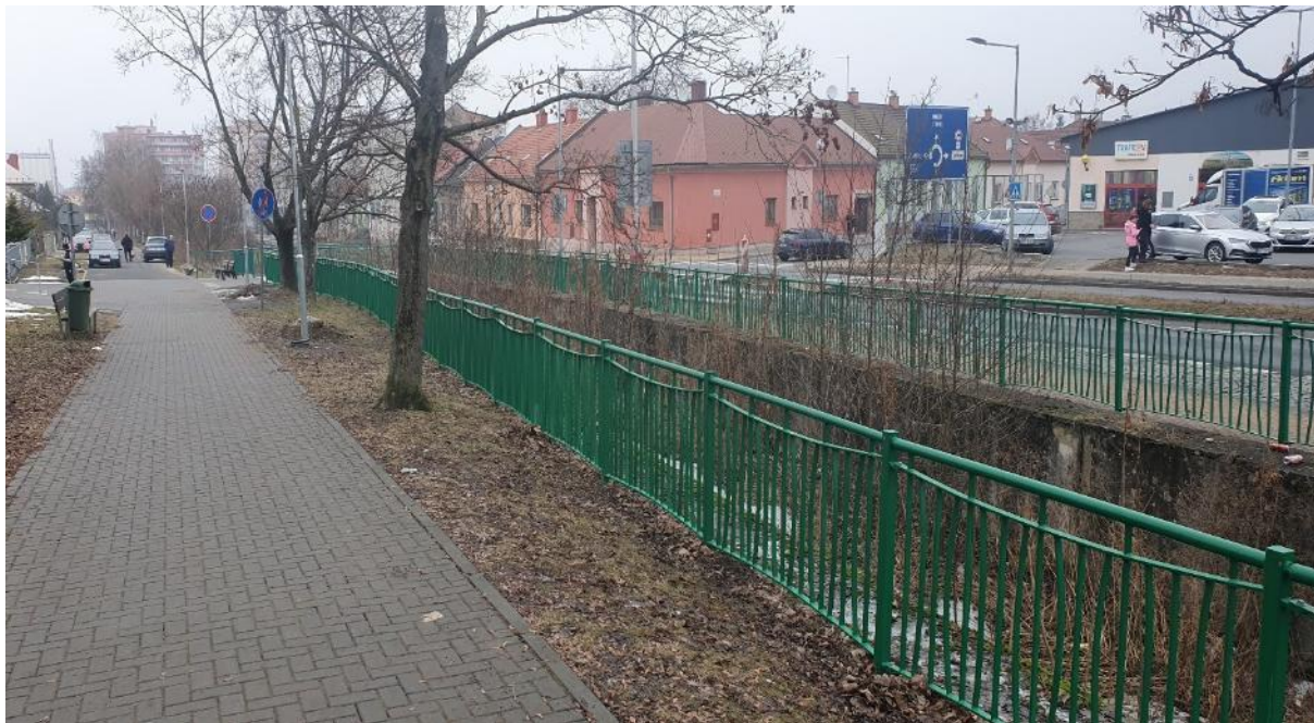
Šternberk, ul. Jívavská – ocelové zábradlí
