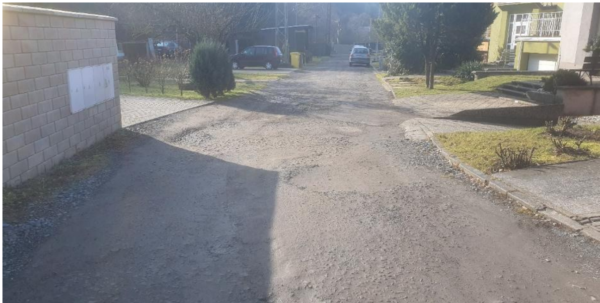
Stavební úpravy komunikace na Světlově, Šternberk
