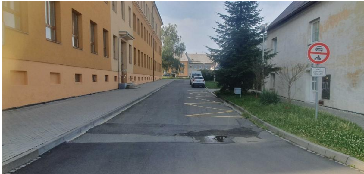
Oprava povrchu místní komunikace Bojovníků za svobodu
