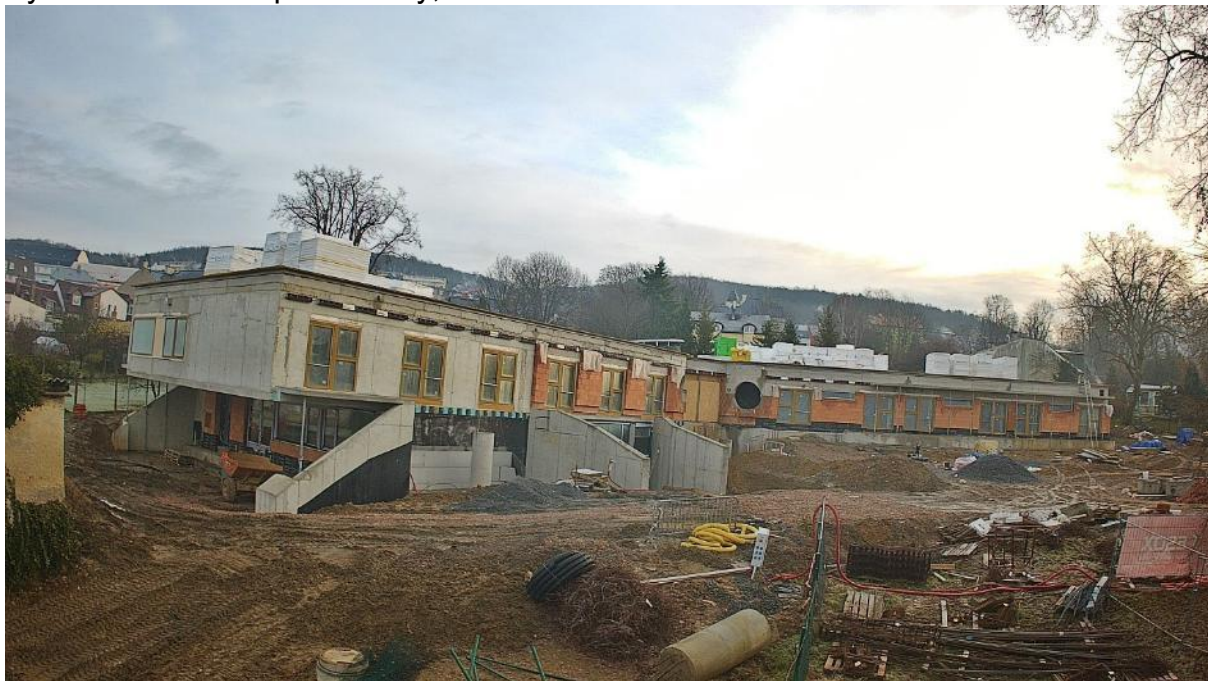
Výstavba Domova pro seniory, Šternberk
