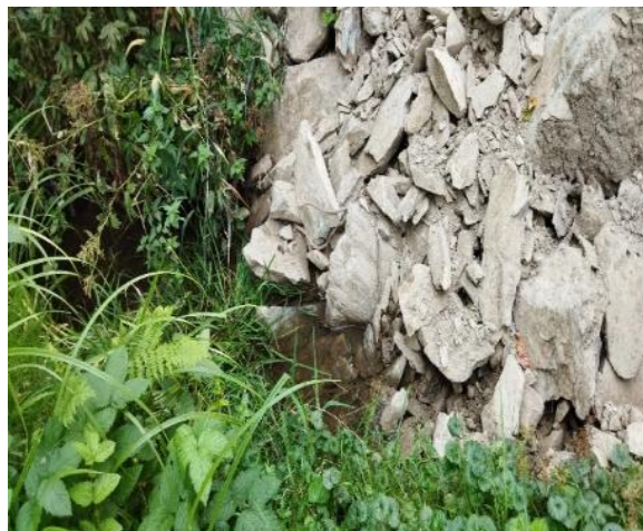
Řízení o odstranění odpadu z vodního toku
