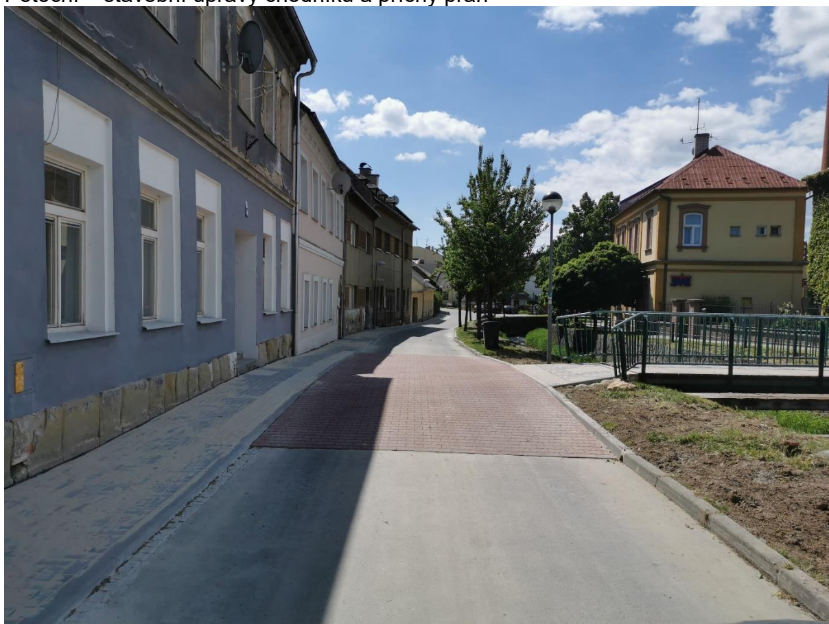
Potoční – stavební úpravy chodníku a příčný práh
