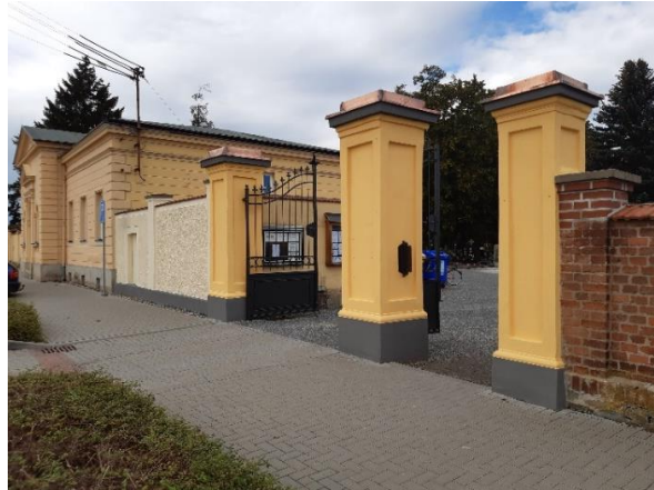
Oprava vstupní brány
