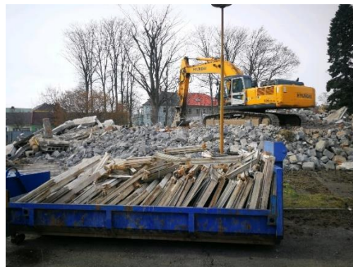
Stav během demolice
