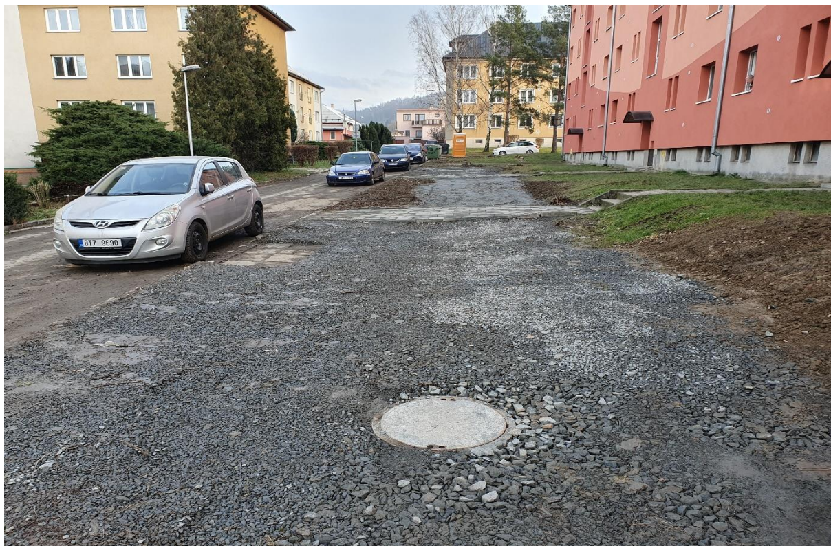
Odkanalizování sídliště Jívavská
