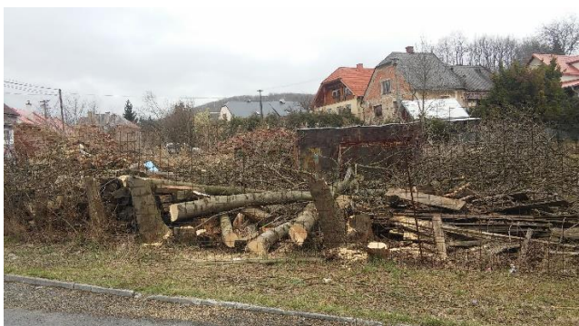
Stav před začátkem úprav
