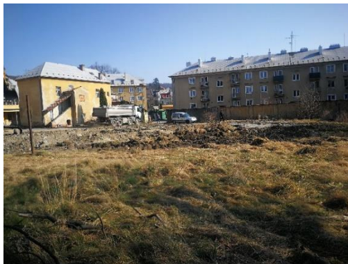
Stav po demolici
