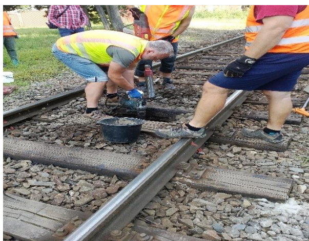
Vzorkování podloží trati Uničov- Šternberk
