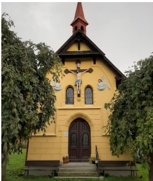
Oprava žlabů a svodů vody na kapli v Chabičově
