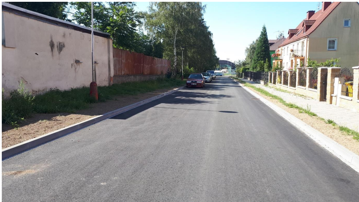
Husova, Poděbradova – nový asfaltový povrch
