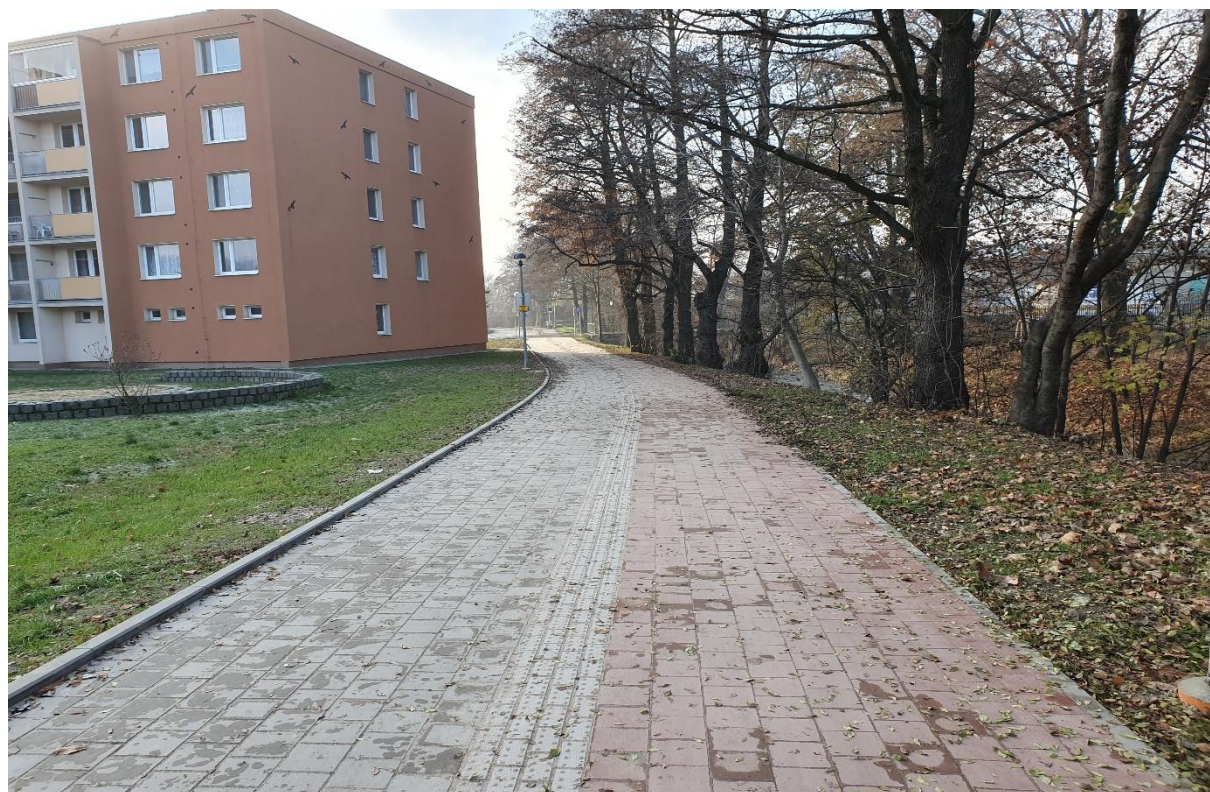
Nábřežní – Pískoviště – výstavba cyklostezky
