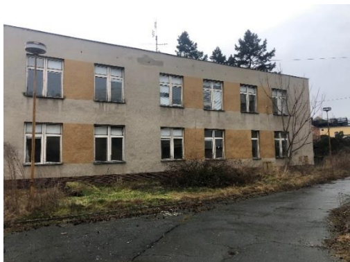
Stav před začátkem demolice
