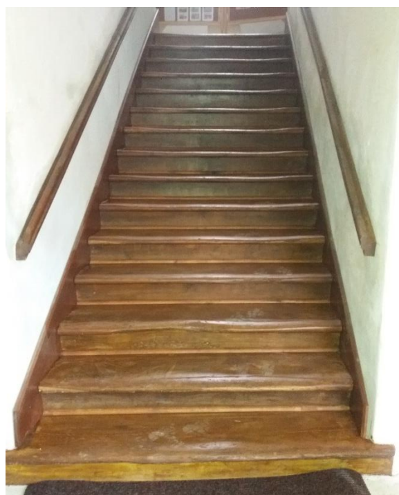
Po restaurování schodiště:
