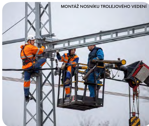
MONTÁŽ NOSÍKU TROLEJOVÉHO VEDENÍ
