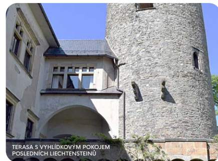
NOVORENESAŇNÍ CHODBOVÁ PŘÍSTAVBA Z KONCE 19. STOLETÍ
