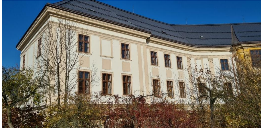
fasáda po obnově
