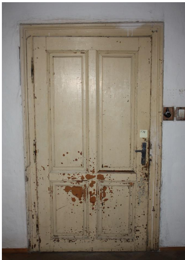
Před renovací dveří:
